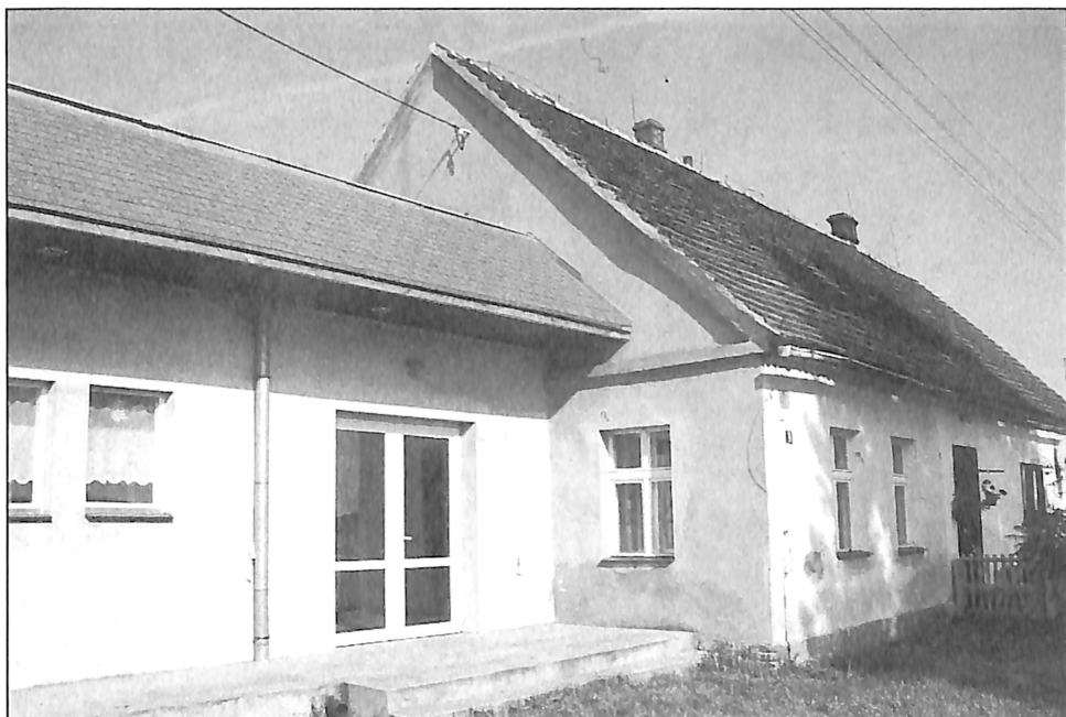
Świetlica we Frankowie z dobudowanym zapleczem
