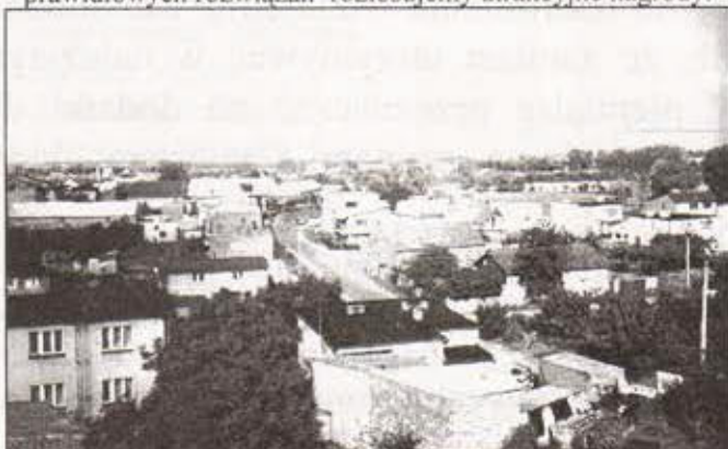
Widoki z wieży remontowanego kościoła poewangelickiego w Krzywinu
