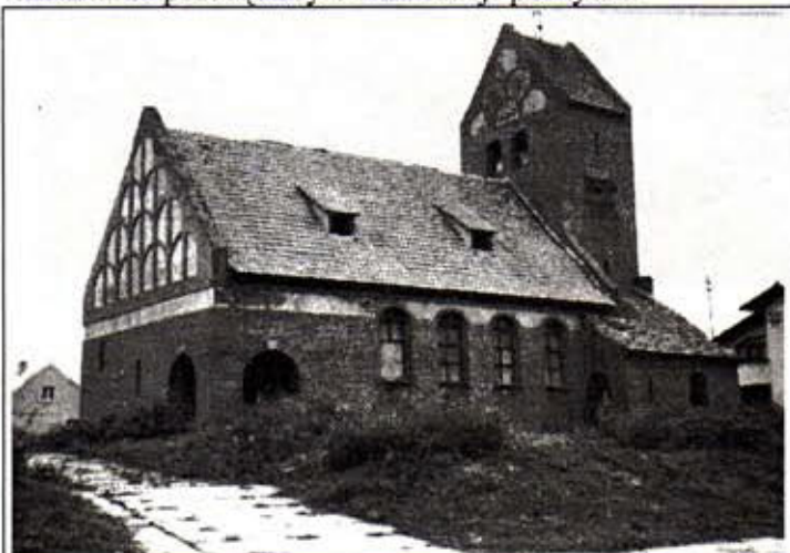
Budynek kościoła poewangelickiego przed remontem. fot.pb
