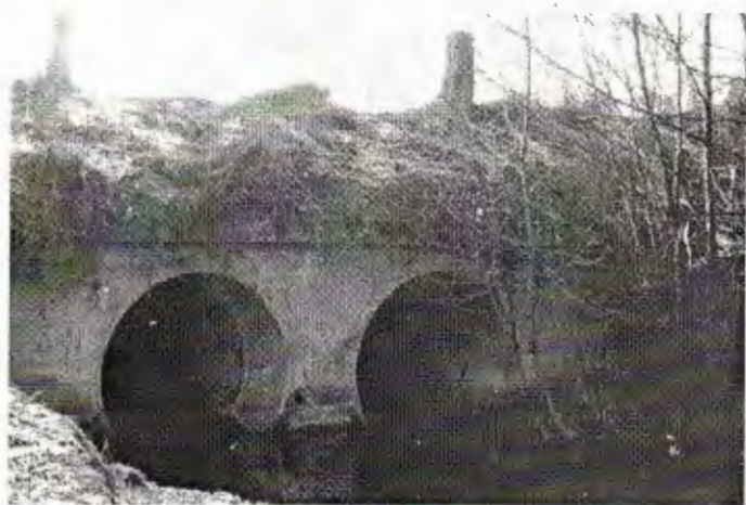
Mostek na kanale między jeziorami. Granica gmin
