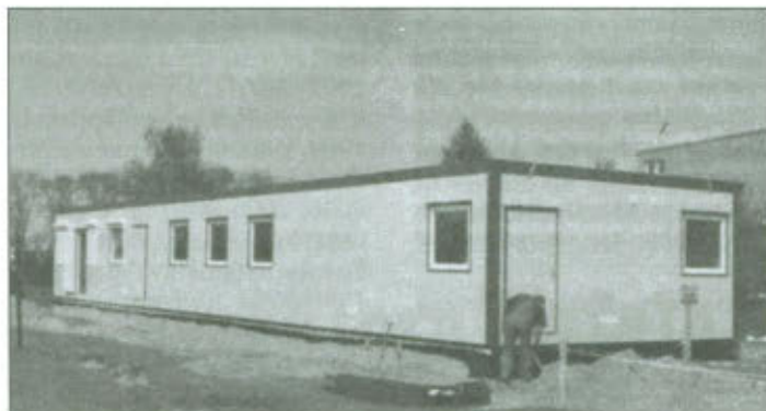
Budowa świetlicy wiejskiej z zapleczem sportowym w Goniemicach
