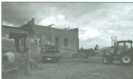
Budowa obiektu firmy „Agrohandel”
