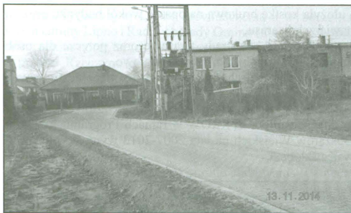
Łącznik między ul. Nową i ul. Spółdzielczą w Lipnie.
