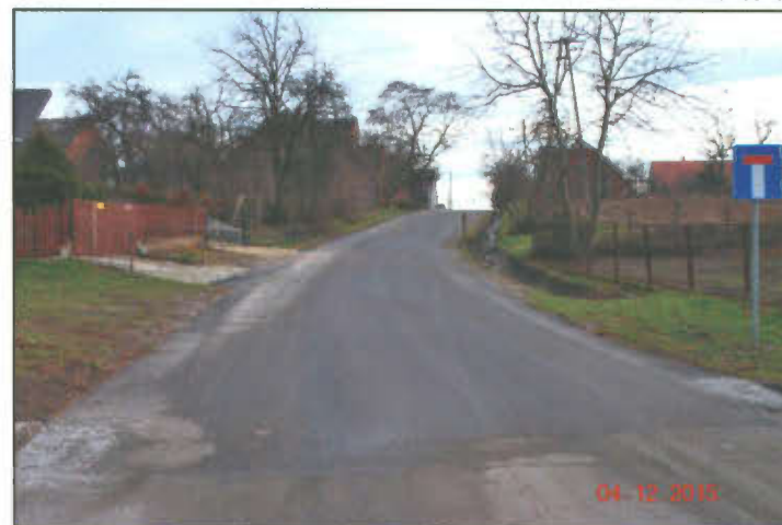
Droga gminna w Targowisku po modernizacji.
