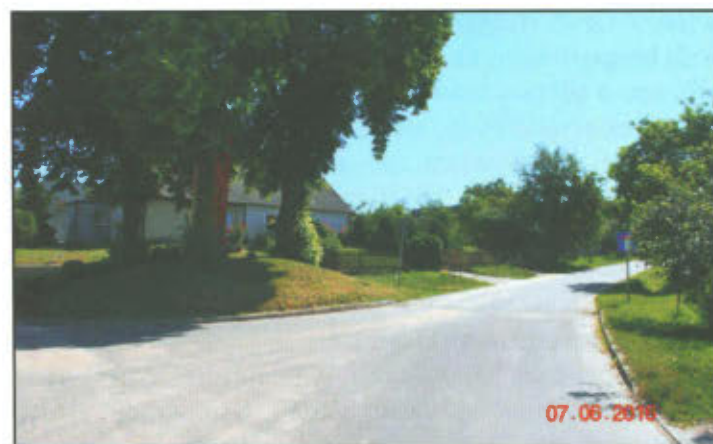
Zmodernizowana droga w Targowisku.
