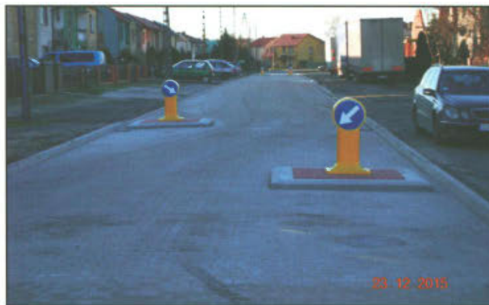
Ul. Nowa w Lipnie.
