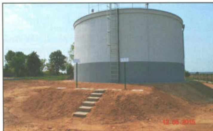
Zbiornik wody pitnej w Maryszewicach.
