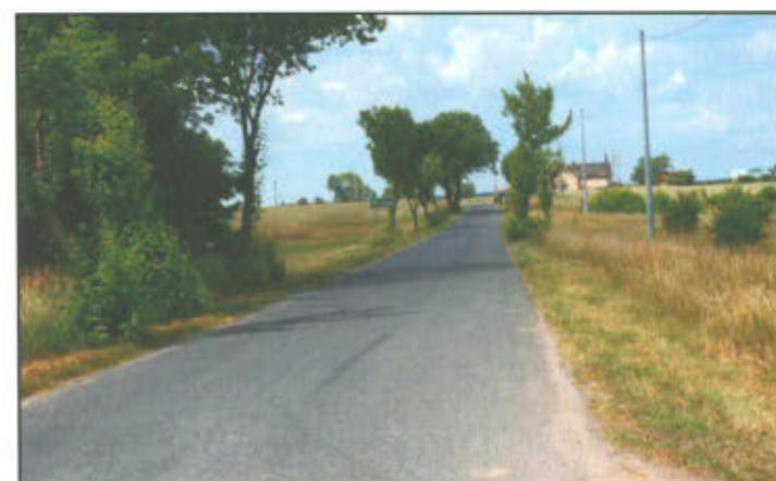
Zmodernizowana droga w Klonówcu.
