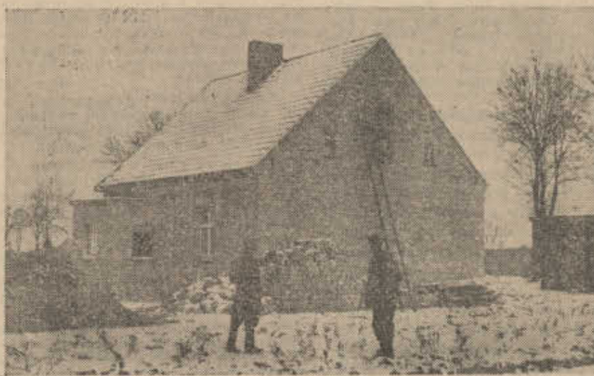
W tym domku nowowybudowanym w spółdzielni produkcyjnej Lipie zamieszka rodzina St. Wawrzyniaka. Nowe zabudowanie otoczył ładny ogródek kwiatowy. W tej samej spółdzielni zbudowano w tym roku jeszcze jeden taki domek. Po 3 domki rocznie buduje spółdzielnia produkcyjna w Kuczynie.
