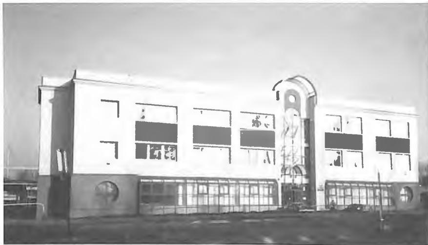
Urząd Skarbowy w Kościanie, po rozbudowie
