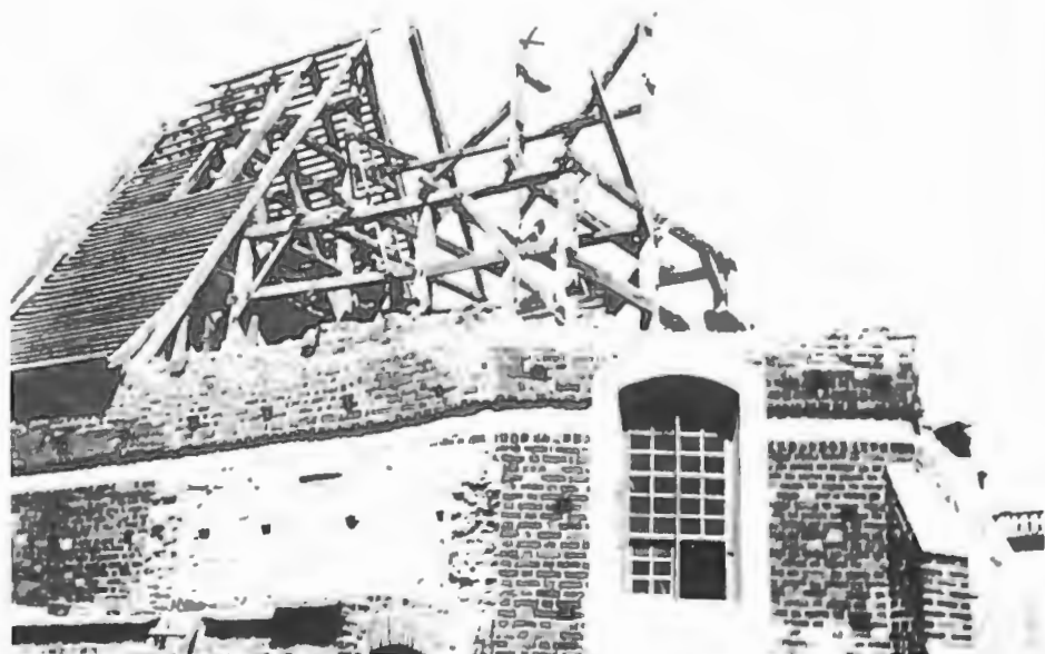
Kościół Świętego Krzyża w czasie rozbiórki
