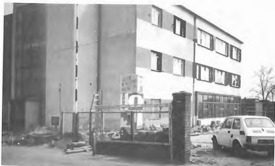
Urząd Skarbowy w Kościanie, przed rozbudową
