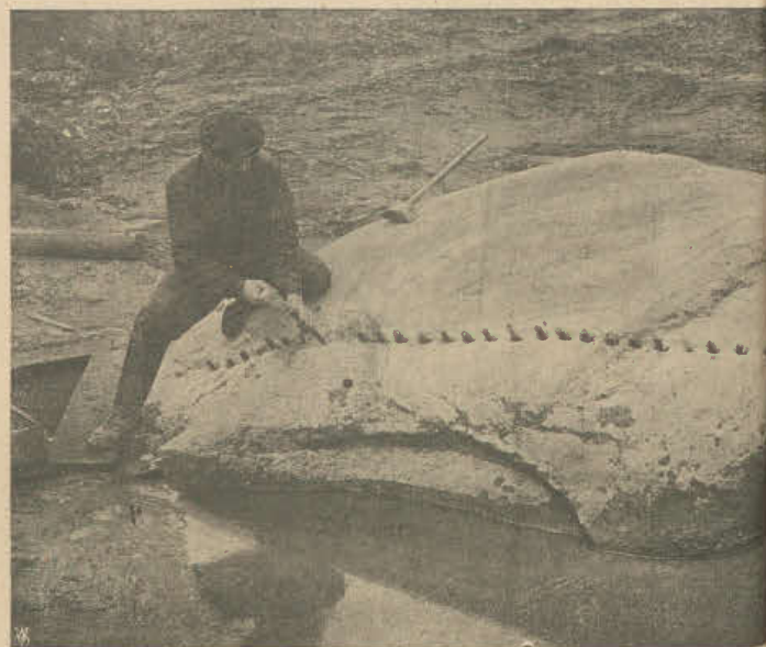
Olbrzymi głaz, wykopany przy budowie zbiorników wodociagowych
