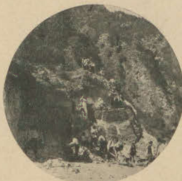
Budowa tunelu w górach alpejskich.
