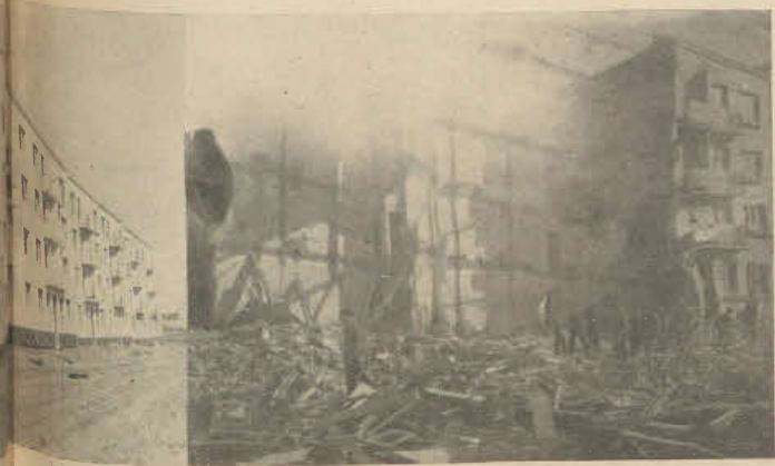
Przewodników gazowych w budynku Związku Ubezpieczeń Prac. Umysłowych w Budynek przed eksplozją i po wybuchu.
