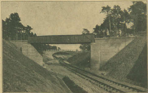
Szlakiem węgla polskiego. Wiadukty (kolejowy i szosowy) pod Bydgoszczą.
