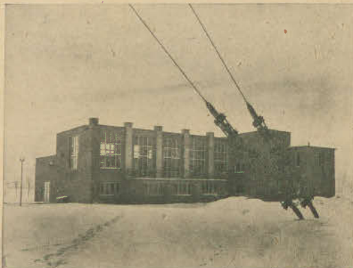
Właściwy budynek stacji nadawczej, widziany z boku. Na przednim planie zakotwiczenie masztów antenowych.
