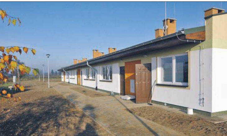
Miasto wkrótce odda do użytku blok socjalny w Gronowie
