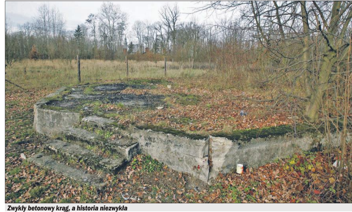
Zwykły betonowy krag, a historia niezwykła
