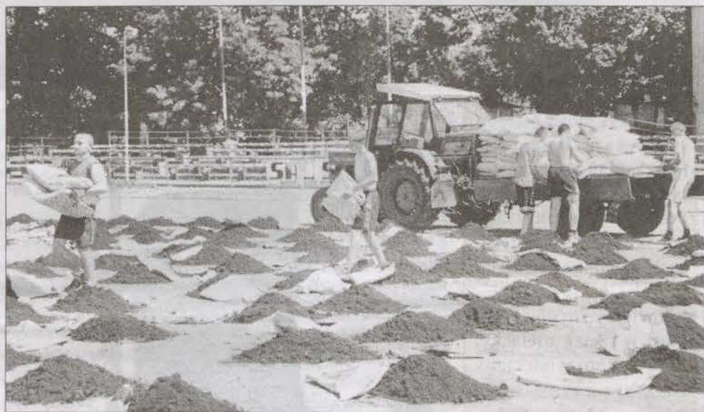
Prace remontowe murawy rozpoczęto jesienią ub. r.
