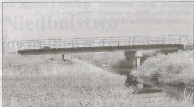
Drewnianą konstrukcję zastąpiono żelbetową.
