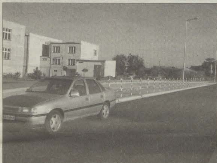
PO GRUNTOWNYM REMONCIE drogę pokonuje się znacznie łatwiej
