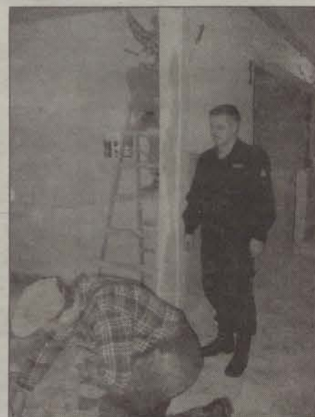
KRZYSZTOF SKRZYPCZAK codziennie obserwuje postęp prac remontowych
