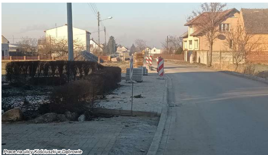
Prace na ulicy Kościuszki w Dąbrowie
