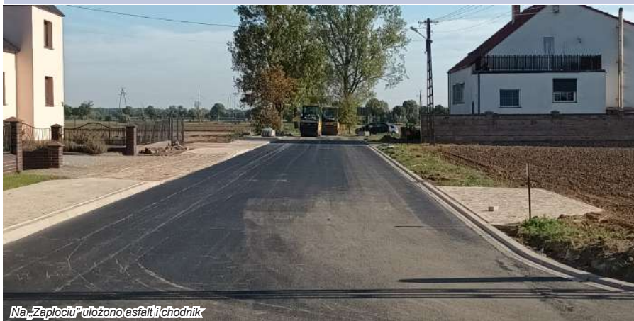
Na „Zapłociu” ułożono asfalt i chodnik
