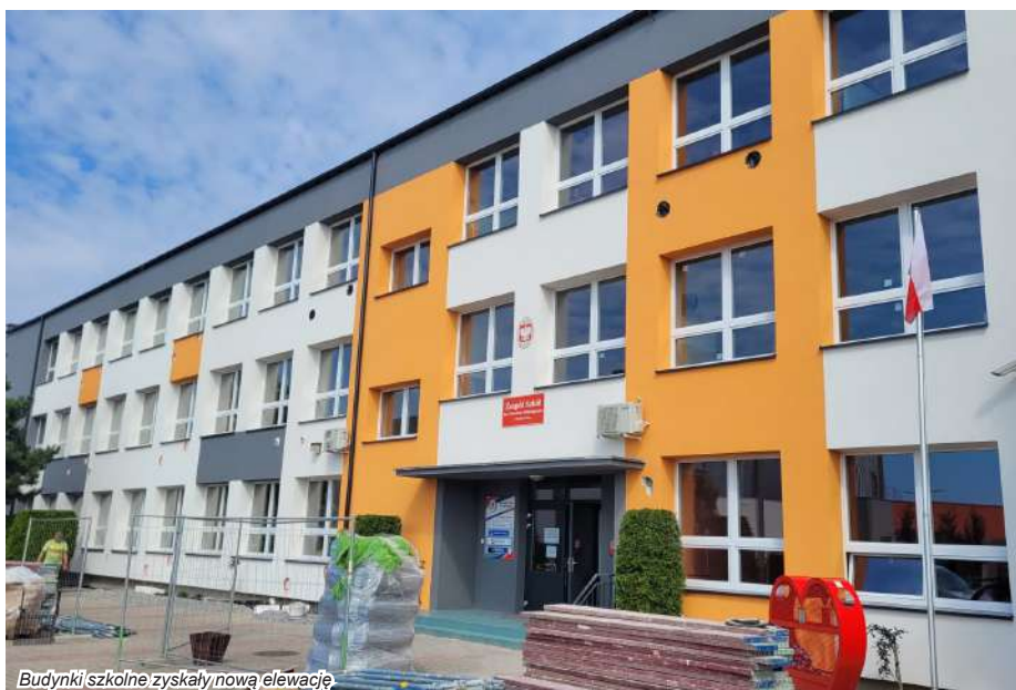
Budynki szkolne zyskały nową elewację
