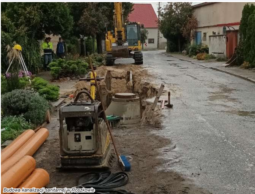
Budowa kanalizacji sanitarnej w Roszkowie
