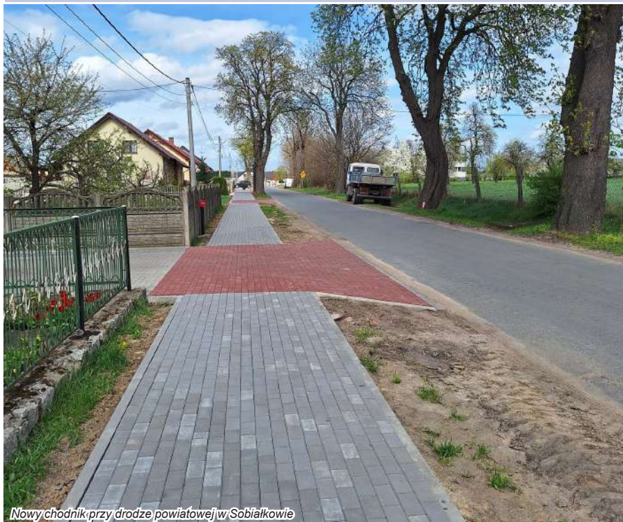
Nowy chodnik przy drodze powiatowej w Sobiałkowie
