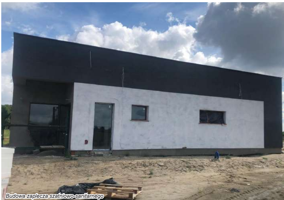
Budowa zaplecza szatniowo-sanitarnego
