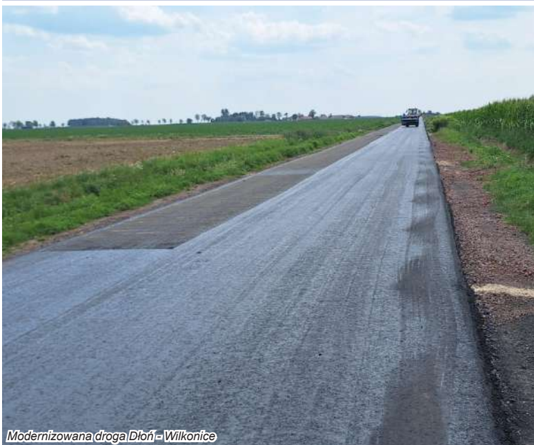
Modernizowana droga Dłoń – Wilkonice
