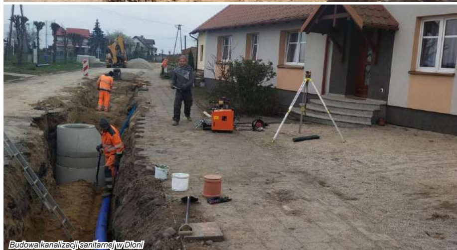
Budowa kanalizacji sanitarnej w Dłoni
