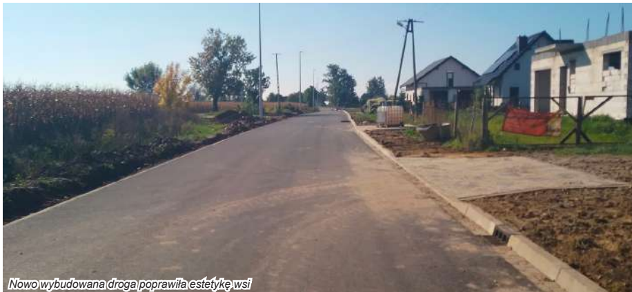
Nowo wybudowana droga poprawia estetykę wsi
