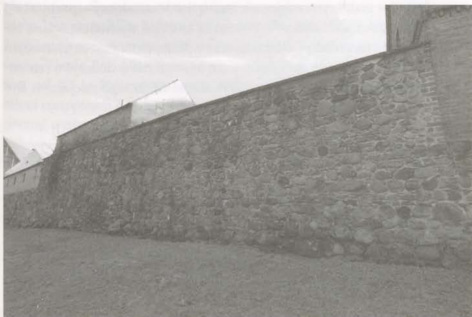
32. Fragment muru obronnego w części północnej obwodu
