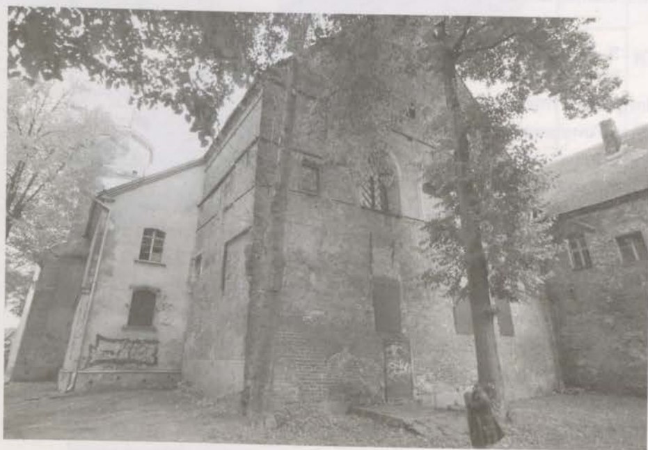
41. Widok na kościół ewangelicki Żłóbka Chrystusa od strony północno-zachodniej z widocznymi pozostałościami bazyliki oraz z zaznaczoną wysokością średniowiecznego założenia
