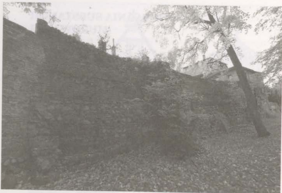
10. Fragment muru w północno-wschodniej części obwodu
