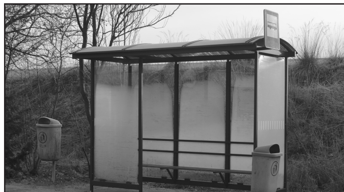
W tym roku zakończono zadanie związane z wymianą wiat przystankowych, które realizowano przez cztery lata.
